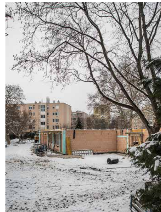
Kertész úti óvodaépítés
