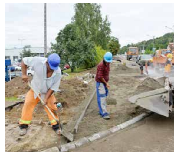
Kerékpárút építése a Kistályai úton
