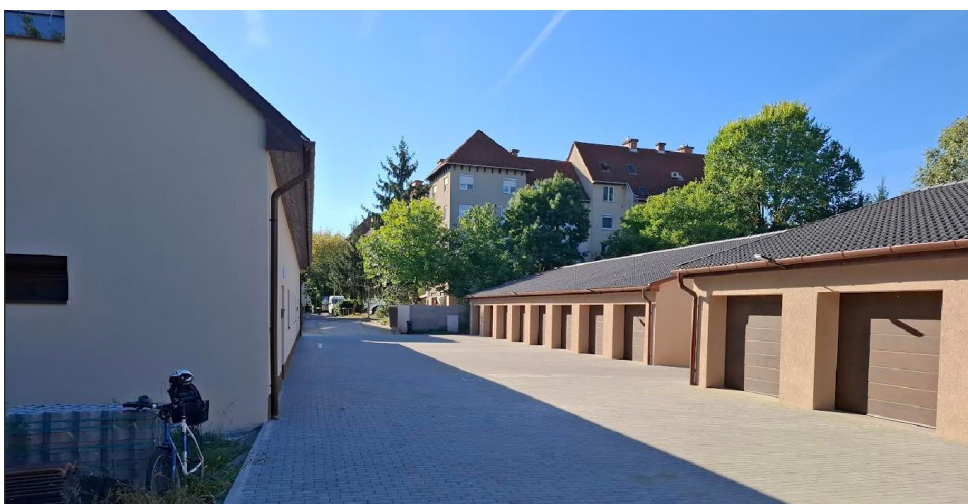
2. kép: A terület bejárata belülről nézve, a társasházak irányába. Jobbra a megvalósult garázsok, balra az irodaépület.
