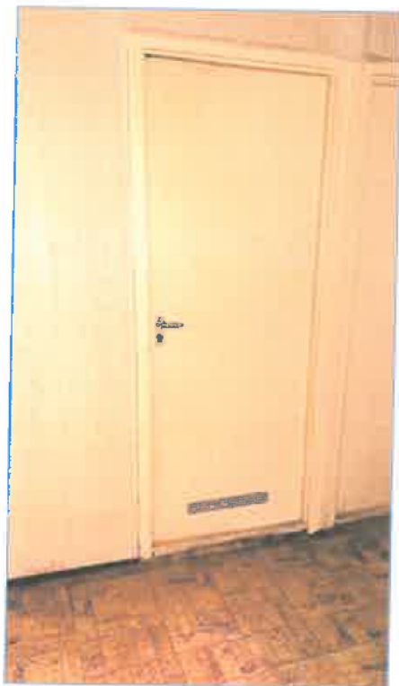
A kompresszorház bejárata
