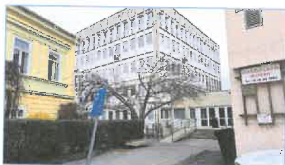
A társasház/irodaház utca felőli nézete
