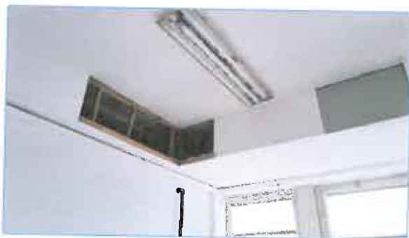
Gépészeti vezetékek borítás hiányossága
