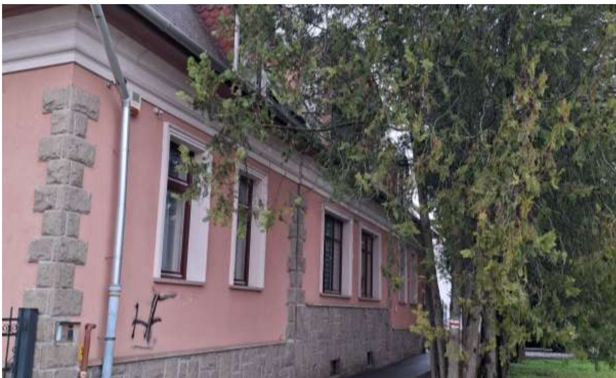
(6. kép) Eger, Vasút utca 10. szám (6774 hrsz) Vasút utcai homlokzat (forrás: Tervező)
