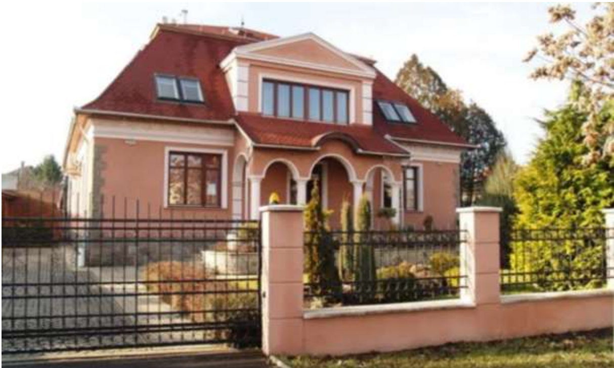
(1. kép) Tárgyi épület vasútállomás felőli homlokzata (forrás: Megrendelő)
