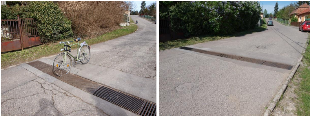
67. ábra: Balra - 2015, Sándor utca - egy szélesebb kerék is könnyen elakadhat a hosszirányú rácsokban
