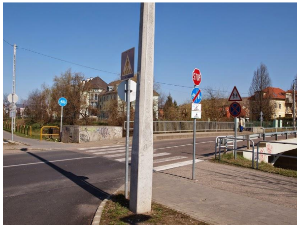
64. ábra: Malom utca - a kerékpárút keresztezésében hiányzik a kerékpáros átvezetés, STOP tábla rendeli alá a kerékpárutat, miközben Hajtva tilos, tolvaj szabályos tábla is kikerült
