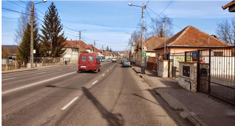
65. ábra: A 25. számú főút felnémeti szakaszán a szélső sávot gyakorlatilag parkolósávnak használják, így a gépjármű-forgalom gyakorlatban csak 2x1 sávban zajlik
