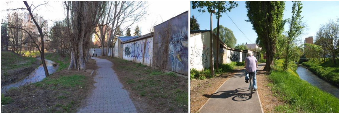
73. ábra: Előtte-utána: az Olasz u. és Rezeda u. közötti kritikus állapotú szakasz felújításra került
