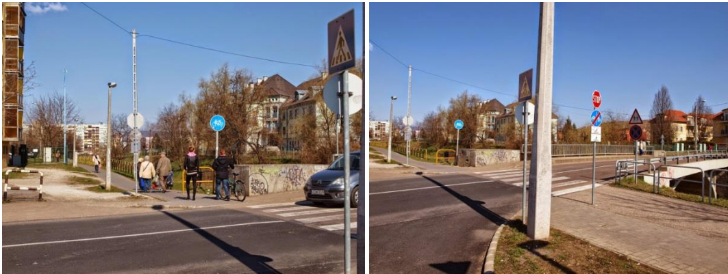
45. ábra: Balra: Malom utcai hiányzó kerékpáros átvezetés. A szakaszon megszokott kép: a felület szélessége nem elegendő a közös gyalogos-kerékpáros használatra Jobbra: STOP, valamint „Hajtva tilos, tolva szabályos!” táblák helyett megfelelő kerékpáros átvezetésre van szükség
