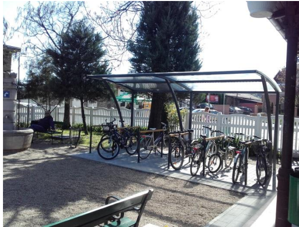
7. ábra: Jó példa a vasútállomás új, fedett B+R parkolója. A bővítésére hamarosan szükség lesz.
