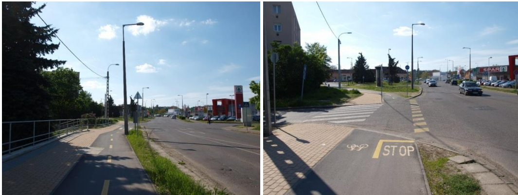
60. ábra: Balra - Gyalog- és kerékpárút a Sas utca déli oldalán Jobbra - Megtévészti útburkolati jel, a kerékpárút valójában elsőbbséget élvez
