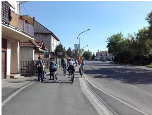
39. ábra: Szűkület a Mátyás király út gyalog- és kerékpárútján a buszmegálló miatt: rendszeres a gyalog- és kerékpárral közlekedők közti konfliktus, ami a kialakítás közvetlen következménye
