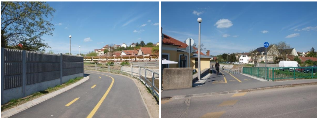
46. ábra: Balra - A csőhíd és a zajvédőfal miatt az ív beláthatatlan és éles Jobbra - A kerékpárút csatlakozása az Árva köznél a szegély lesüllyesztése nélkül
