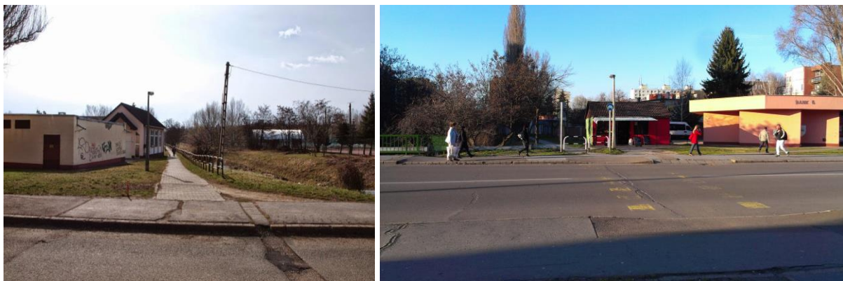
44. ábra: Balra - Kiemelt szegéllyel indul a Bükk stny. menti kerékpárút Jobbra - Lekopott kerékpáros átvezetés az Olasz utca keresztezésében
