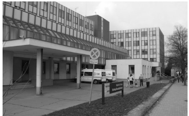
60. ábra Kórház épülete
