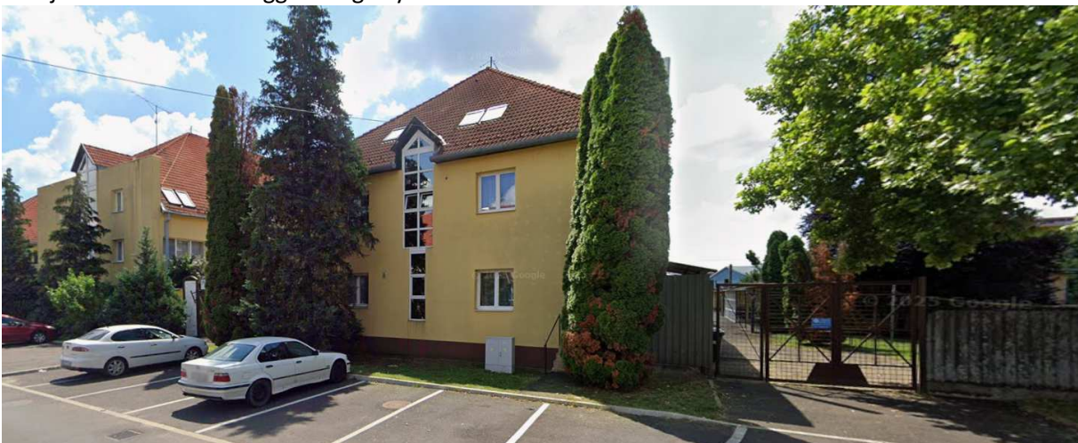
A Külső sor utca menti Motel Botax szálláshely szolgáltató épületegyüttese. A kontyolt nyeregtetős épület osztott tömege kedvezőbb településképi megjelenést eredményez.
