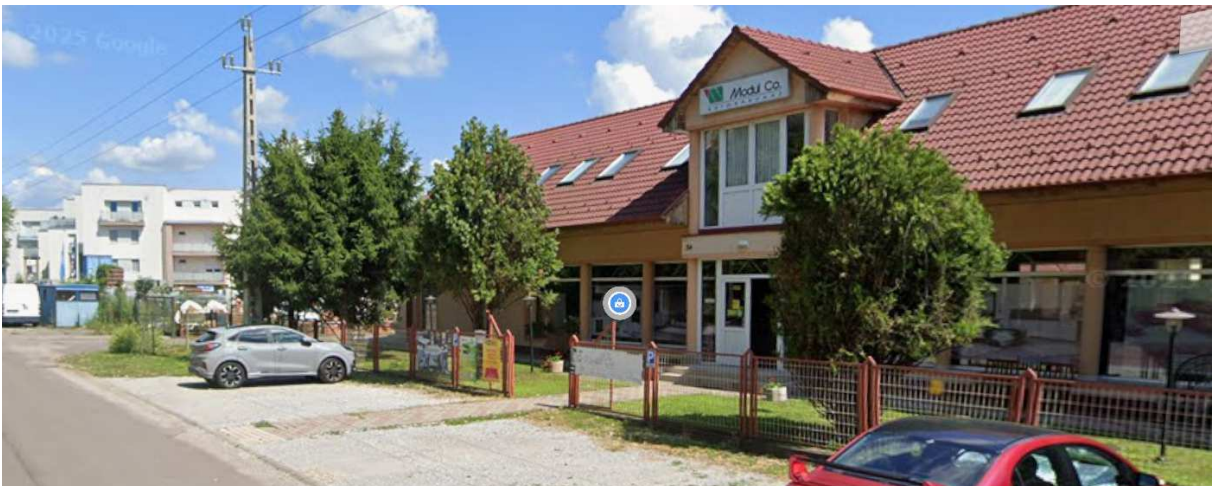
A fejlesztéssel érintett telektől keletre fekvő Modul Co. bútoráruháza telke. Utcával párhuzamos nyeregtetős épülettetősíkjában fekvő tetőablakokkal, cserépfedéssel és portálsorral a homlokzaton. A főbejárat vertikális tömeggel hangsúlyozott.
