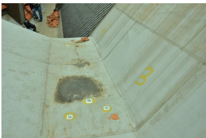
7.sz. archív fotó Az Észak-Keleti oldali vápában lévő lefolyó és környezetének képe. A tetőfelületen csekély lejtés mellett pangó vízfelület is látható. Itt is utólagos javítás látható.
