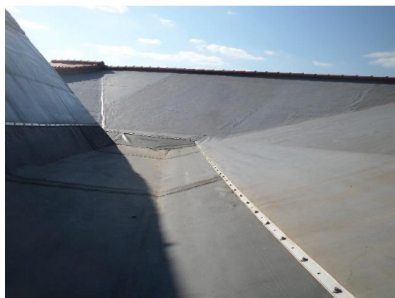
12-13.sz. fotók Ugyanezen vápa Észak-Nyugati sarokrészén is hasonlóan a régi PVC-P szigetelés a felső soron látható, a felújítás során elhelyezett lemez pedig alul helyezkedik el. Erre van ráragasztva és szorító fémszalaggal rögzítve az EPDM vápa bélelő lemez. A tervezett rézlemez letakarás nem készült el. A vápa lejtése a felső szakaszon (Nyugati irányba) 1,5 % .
