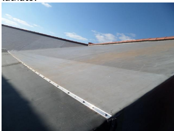
12-13.sz. fotók Ugyanezen vápa Észak-Nyugati sarokrészén is hasonlóan a régi PVC-P szigetelés a felső soron látható, a felújítás során elhelyezett lemez pedig alul helyezkedik el. Erre van ráragasztva és szorító fémszalaggal rögzítve az EPDM vápa bélelő lemez. A tervezett rézlemez letakarás nem készült el. A vápa lejtése a felső szakaszon (Nyugati irányba) 1,5 % .
