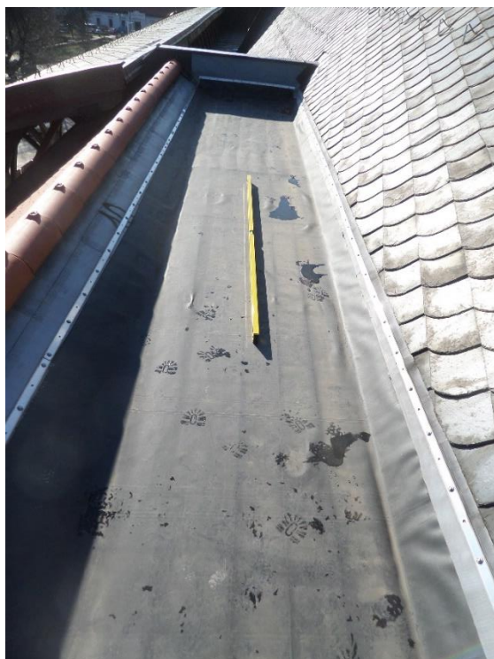
49.sz. fotó továbbiakban az 1-es számmal jelölt tetőfelület Dél-Keleti sarokrészénél a vápa itt is csak EPDM lemezzel bélelt, amely az eredeti PVC-P lemez alá van befűzve és fémszalaggal illetve dűbelekkel lerögzítve.
