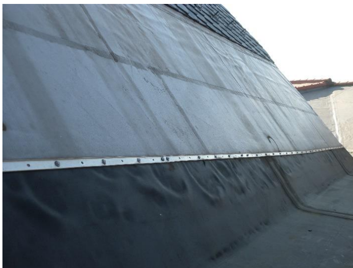
10.sz. fotó Az EPDM lemez és PVC-P lemezek csatlakozása a vápa sarokrészén.
