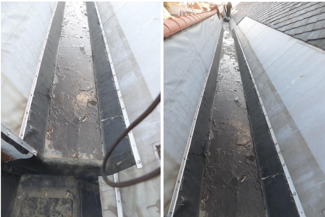
29-30.sz. fotó A hosszoldalon lévő kiemelt homlokzat mögötti harmadik vápa EPDM lemezzel bélelt, de lejtése nincs . A vágásban végig pangó, álló, lefolyástalan vízfelület látható.
