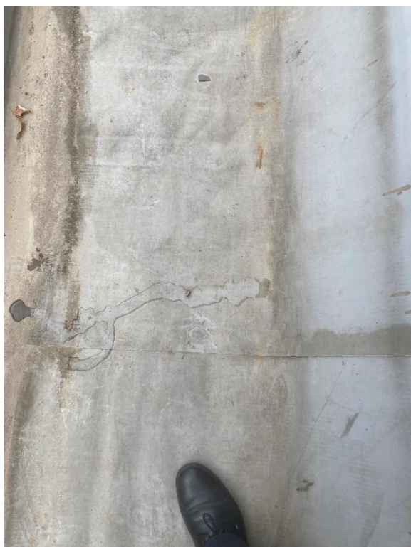
23.sz. archív fotón jól látható az eredeti, régi PVC-P lemez szigetelés és a vápa bélelésére kivitelezett/lefektetett új, felújító PVC-P lemez csatlakozási határa.
