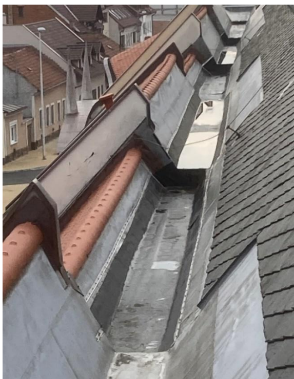
25.sz. archív fotó az Észak-Keleti hosszoldal első vápájáról. A vápa fenékszintjén porsár szennyeződés nyoma látható, ami pangó, lefolyástalan vízfelület meglétét igazolja.
