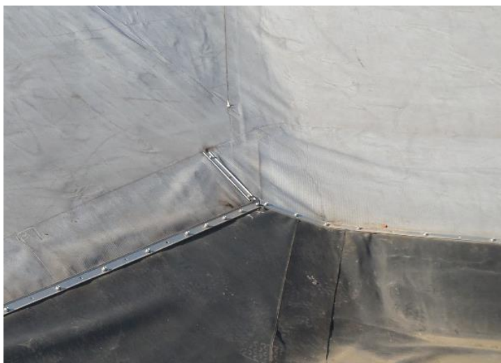
18.sz. fotó az Észak-Nyugati vápa sarokrészének kialakítása. A vápa lejtése itt 1 %-os és helyenként pangó vízfelület porsár szennyeződése is látható.
