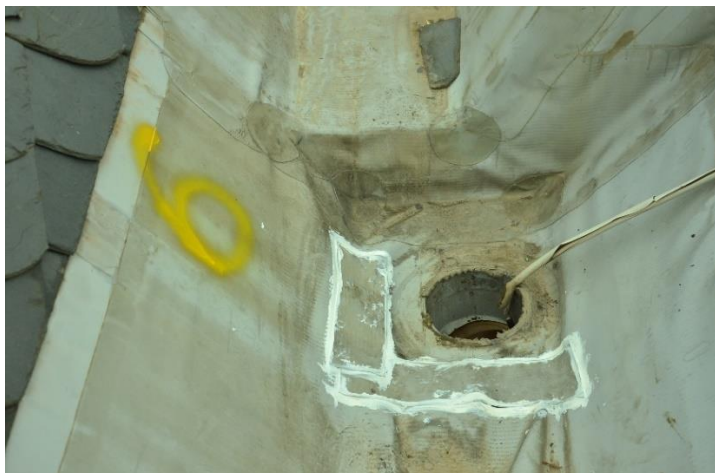
9.sz. archív fotó További lefolyó és környezetének felvétele az Észak-Keleti oldalon. Az összefolyó környezetében a PVC-P lemez nagymértékű gyűrődése látható. A szétvágott lemez a feltárás része.
