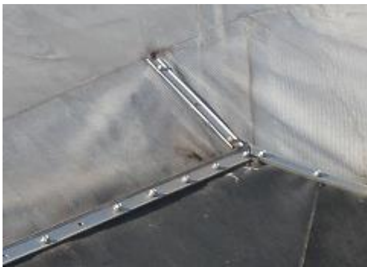
19.sz. fotó A sarokrészen az EPDM lemez toldása, valamint annak csatlakozása a PVC-P lemezhez.
