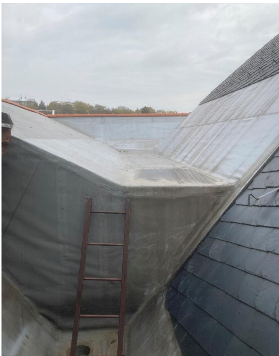
16.sz. archív fotón láthatóan nincs az EPDM lemez lefektetve a vápába, pedig a Tervezői jóváhagyás szerint itt is el kellett volna készíteni.
