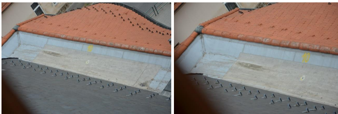
5-6.sz. archív fotó a Főbejárat feletti tetővápát ábrázolja. A tetőfelületen csekély lejtés mellett pangó vízfelület is látható.
