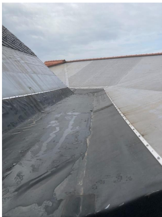
32.sz. archív fotón az Észak-Nyugati sarok látható. A váparész csak a fenékszint felett kb. 30 cm vetületi magasságig fedett az EPDM lemezzel. Egyéb részeken az eredeti PVC-P lemez maradt a tetőfelületen. A PVC-P lemezek tervezett rézlemez takarása nem készült el.
