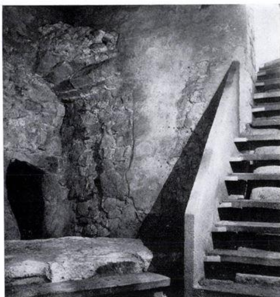
304. kép. Lépcsőlejárát a Földbástyába vasbeton járólapokkal
