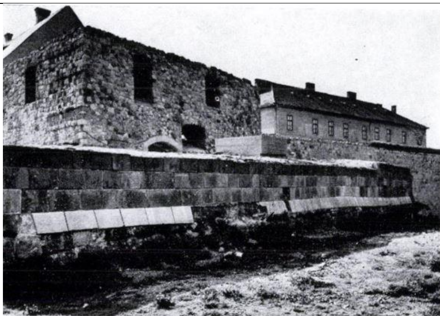
A helyreállított tömlőcbástya északnyugat felől. Kozák 1969. 270. 259. kép.
