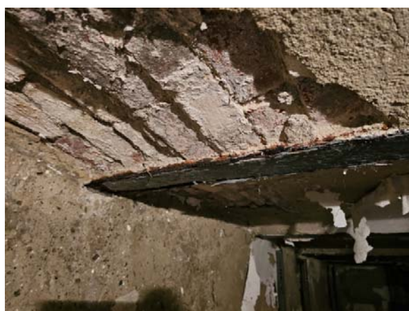
Sérült, kipergett fugázás a boltozaton
