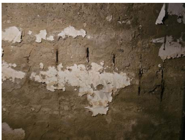
Levált betontakarás a pincefalon
